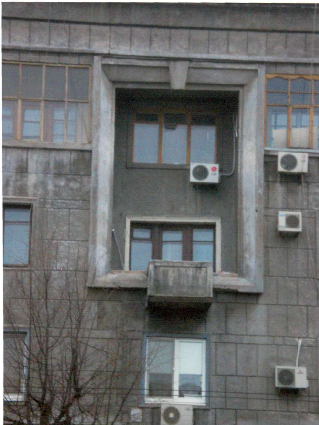
5. Архітектурне оформлення вікон головного фасаду.
