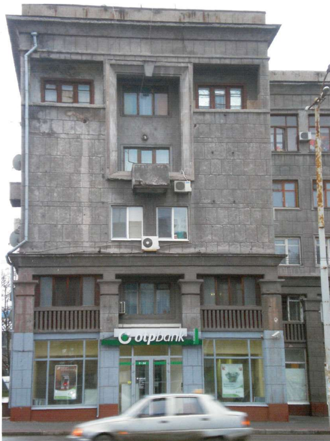
6. Головний фасад південного крила будівлі. Виглад з північного сходу.
