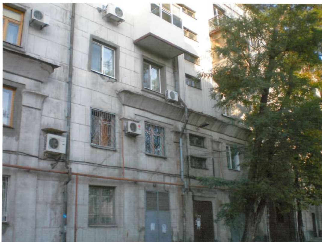
8. Фрагмент тильного фасаду.
