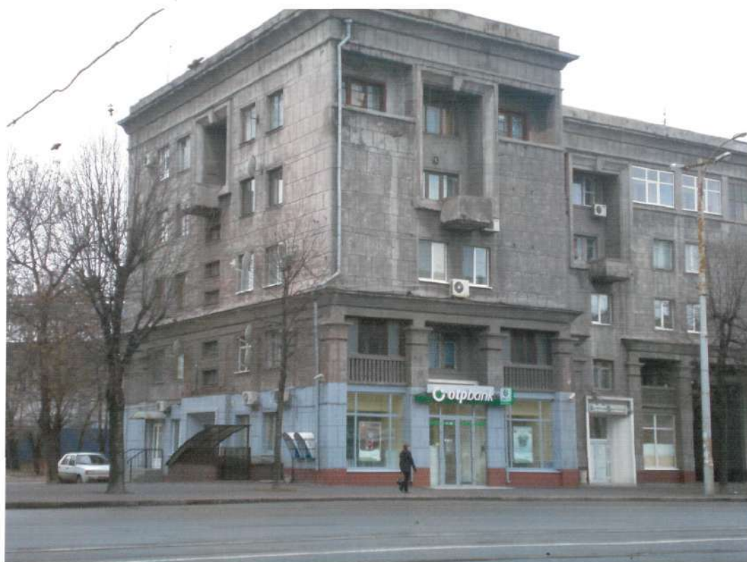
3. Фрагмент головного фасаду зі сходу.
