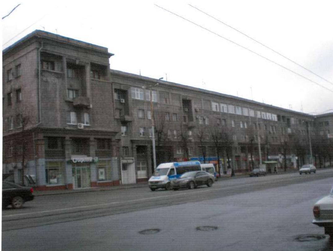
1. Загальний вигляд будівлі з південного сходу.
