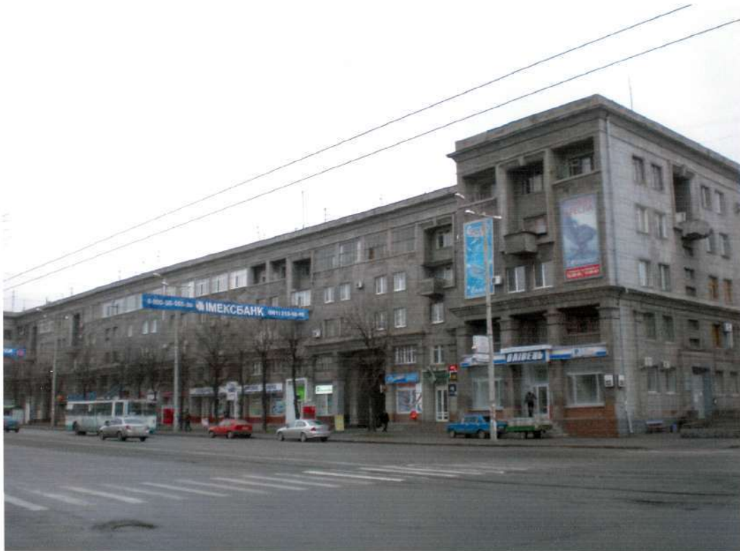
2. Загальний вигляд будівлі з північного сходу.
