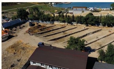
Траншеї зроблені важкою будівельною технікою в культурних шарах Середньовіччя і Нового часу на Некрополі Херсонеса
