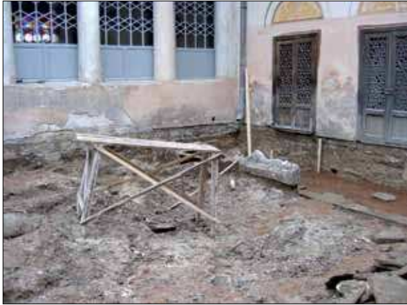
Рис. 254. Бассейновый двор. Восточный фасад Зала Дивана и Летняя беседка. Начало исследований. Фото 2004 г.
