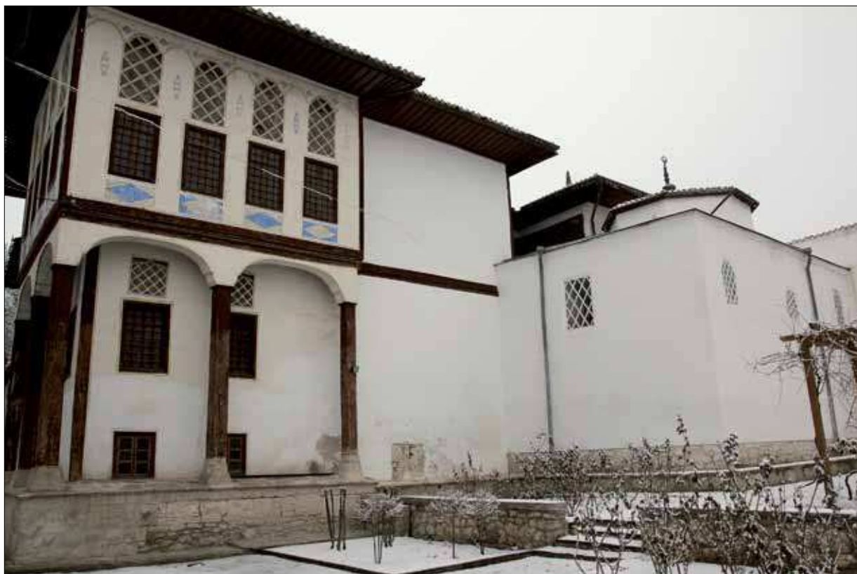
Рис. 121. Главный корпус. Вид со стороны Гаремного корпуса. Справа – южный фасад Малой дворцовой мечети; в центре на втором этаже – южная стена Посольского зала; слева на втором этаже – Кофейная комната, на первом этаже – окна Комнаты евнуха и Казнохранилища. Фото 2013 г.
