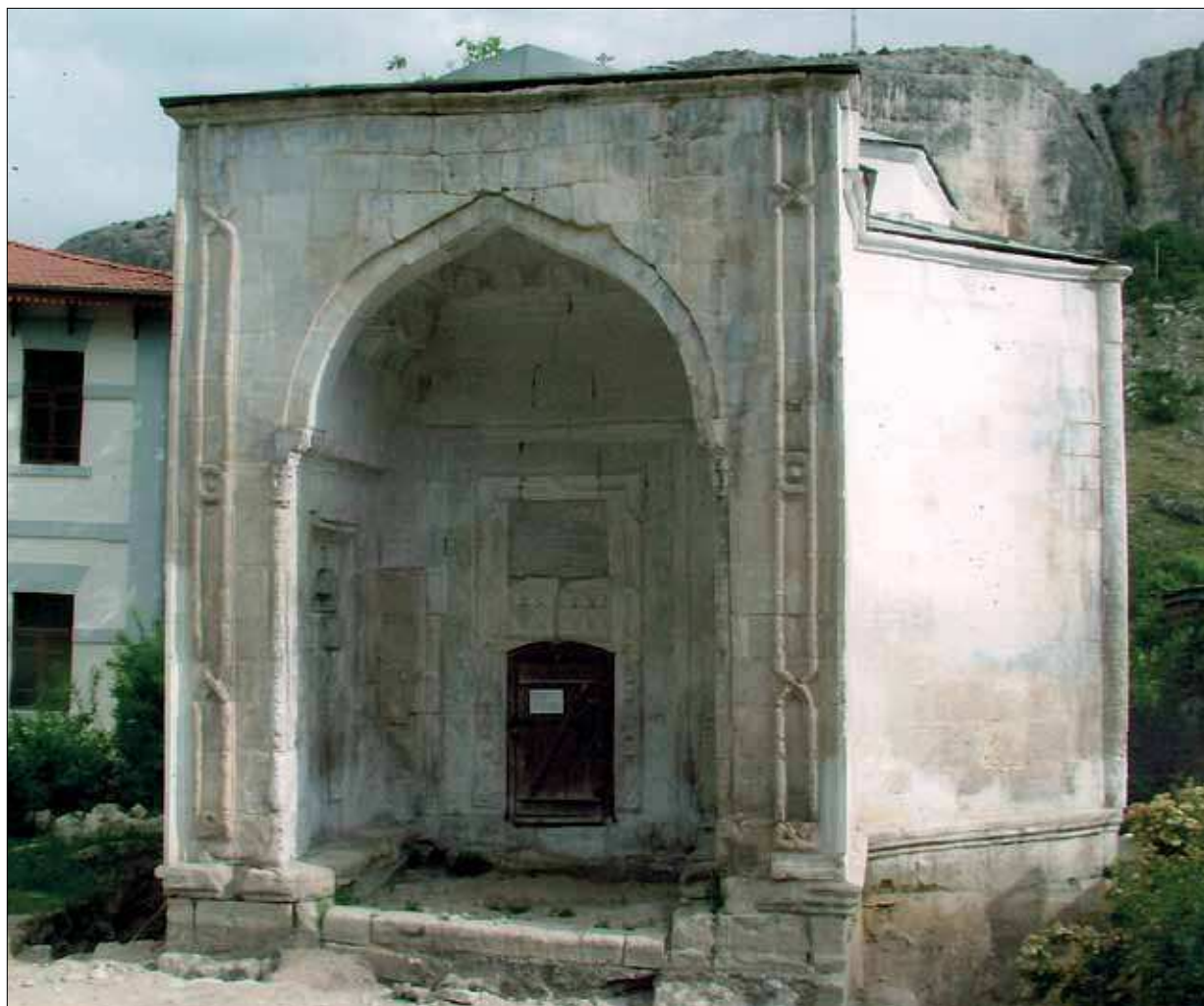
Рис. 270. Дюрбе Хаджи Герая. Перед началом реставрационных работ. Фото 2007 г.
