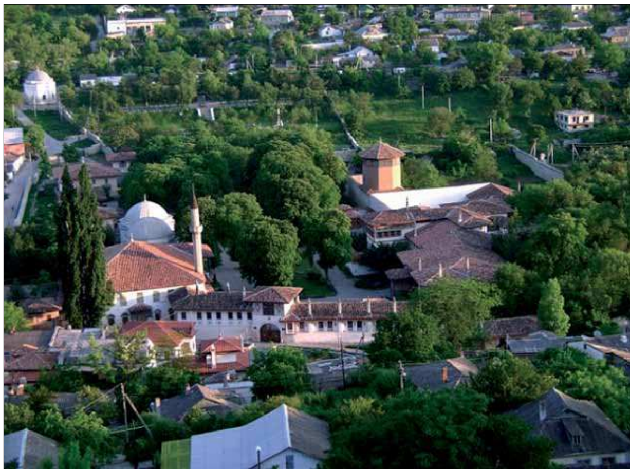
Рис. 1. Бахчисарайский ханский дворец. Вид сверху, с севера. Фото 2012 г.
