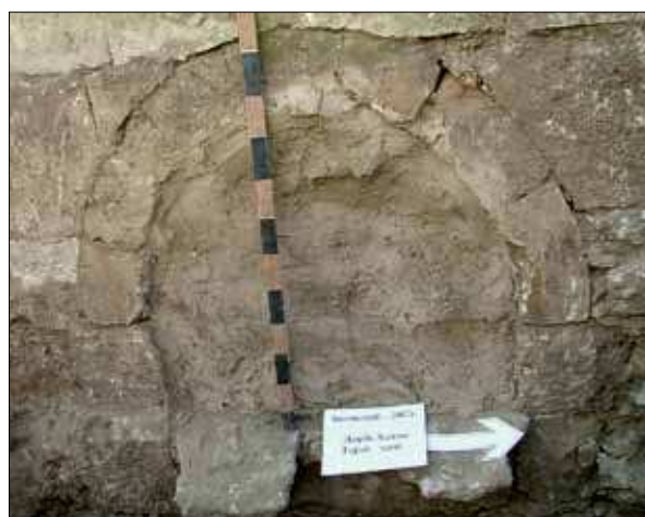
Рис. 293. Дюрбе Хаджи Герая. Замурованный вход в склеп после окончания обследования. Фото 2007 г.
