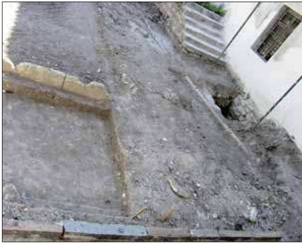
Рис. 265. Бассейновый двор. Шурф у восточной стены Малой дворцовой мечети. Каменная стенка бассейна. Фото 2005 г.
