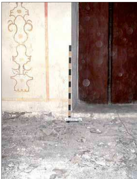
Рис. 258. Главный корпус. Зал Дивана. Сняты поздние полы до уровня 1836 г. Фото 2004 г.
