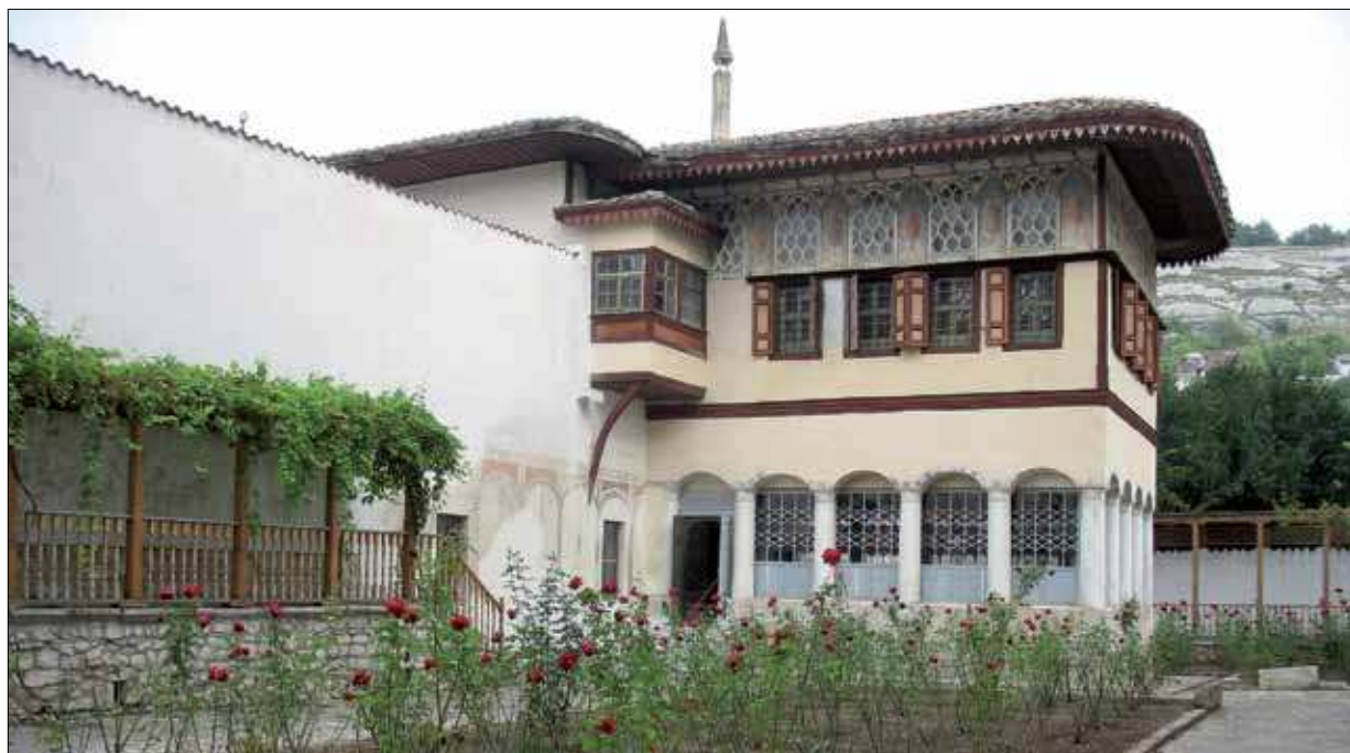
Рис. 119. Главный корпус. Бассейновый дворик. Вид на Золотой кабинет. Фото 2013 г.
