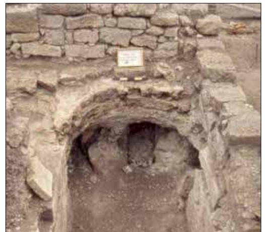
Рис. 249–252. Персидский двор. Хамам № 2. Кюльхан. Видны воздухопроводы для подачи горячего воздуха под пол хамама. Фото 2003 г.
