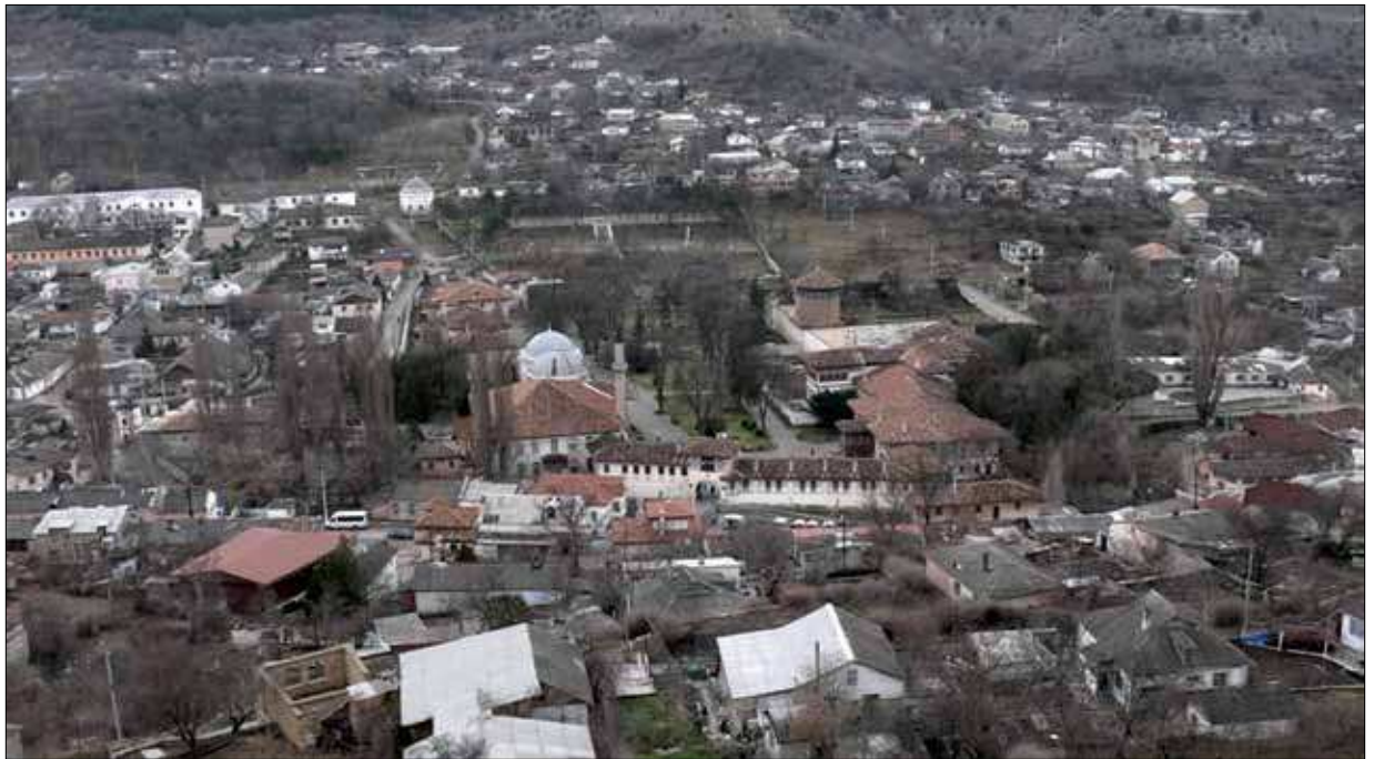
Рис. 68. Бахчисарайский ханский дворец. Вид сверху, с севера. Фото 2012 г.
