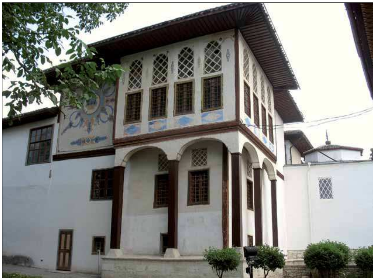
Рис. 122. Главный корпус. Западный фасад.
