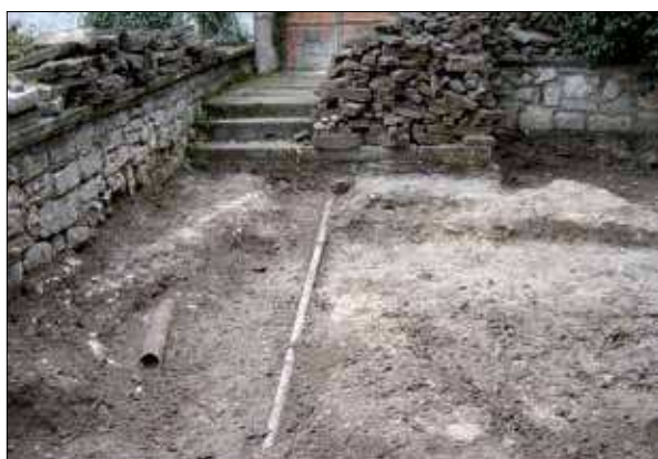
Рис. 214. Гаремный двор. Остатки фундамента кухни и водопровода. Фото 2004 г.
