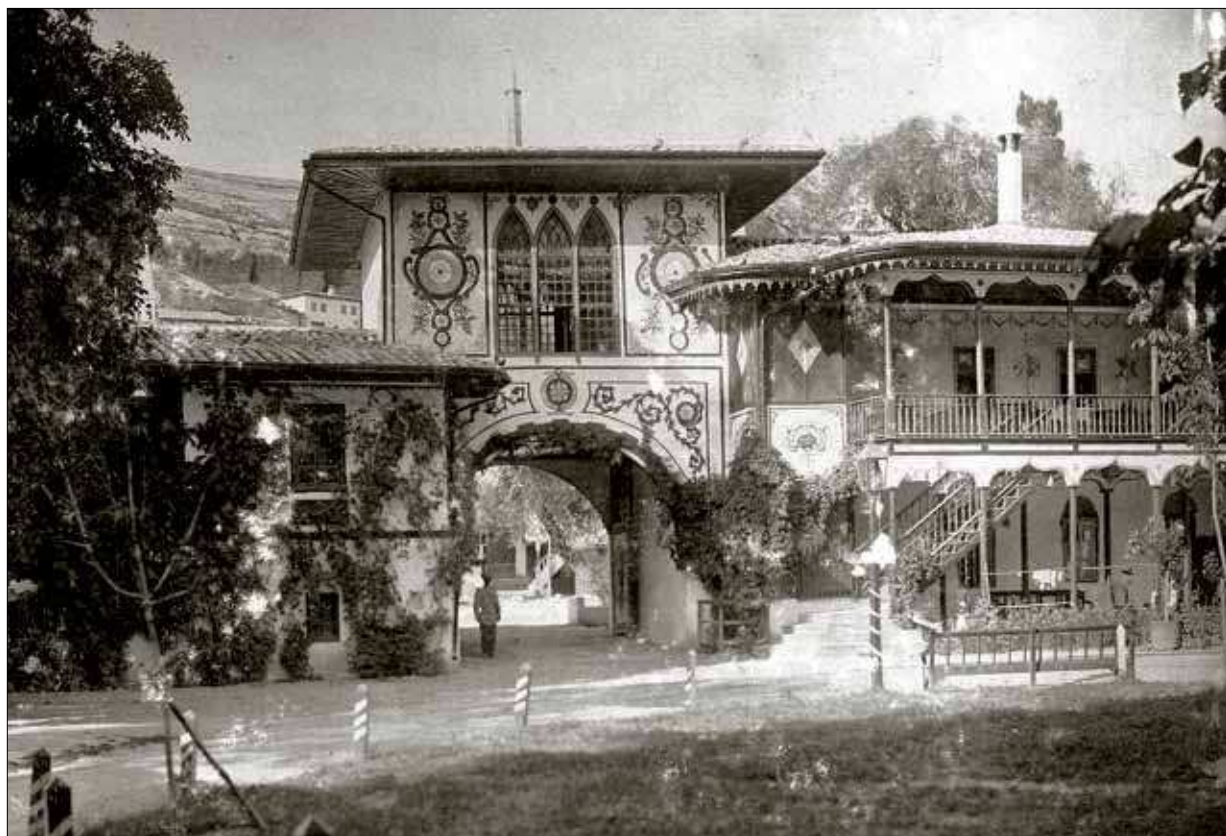
Рис. 170. Северные ворота и помещения стражи. Вид с Дворцовой площади. Фото И.В. Болдырева, 1880-е гг.
